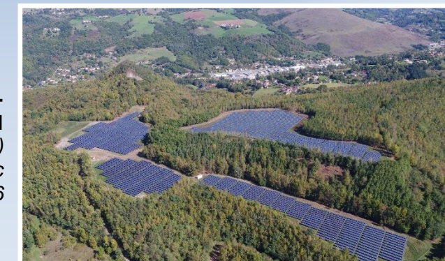
Centrale Solaire de DECAZEVILLE-AUBIN Département de l'Aveyron (12) Puissance électrique : 12 000 KWc Mise en service : Décembre 2016
